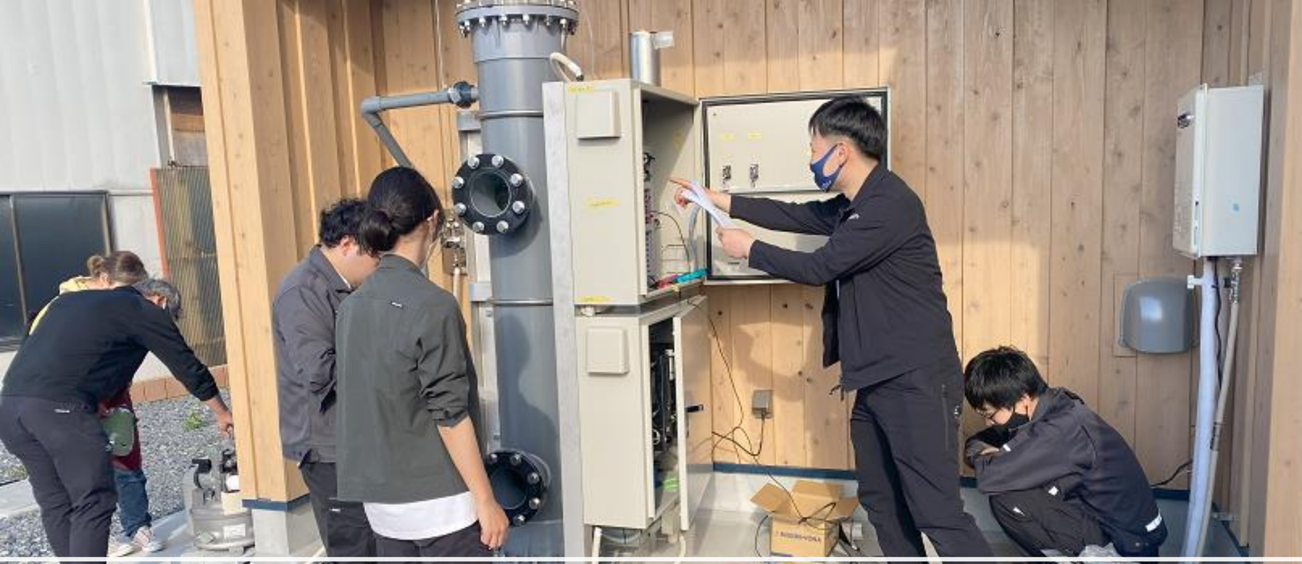
排水浄化システム調整の様子（1）
